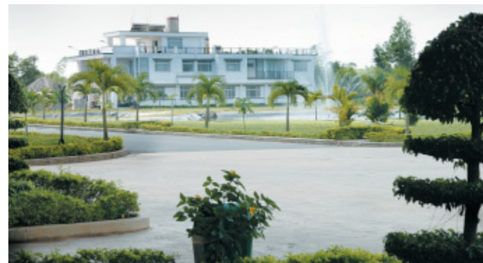
Idyllische Lage: 11 Millionen Dollar investierte das Unternehmen Saigon Tan Tec Leather in seine neue Fabrik mit 310 Mitarbeitern.
